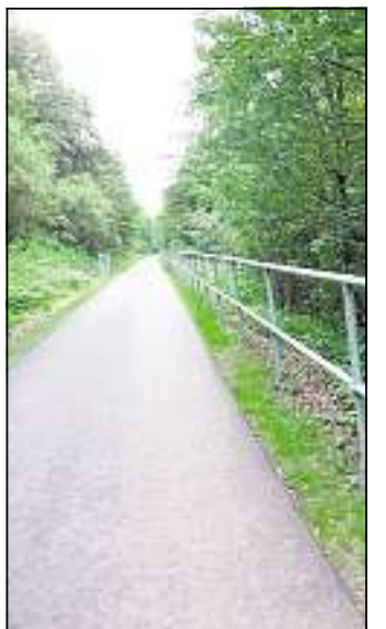
Der Radweg zwischen Georgenthal und Tambach-Dietharz wurde neu gebaut.
