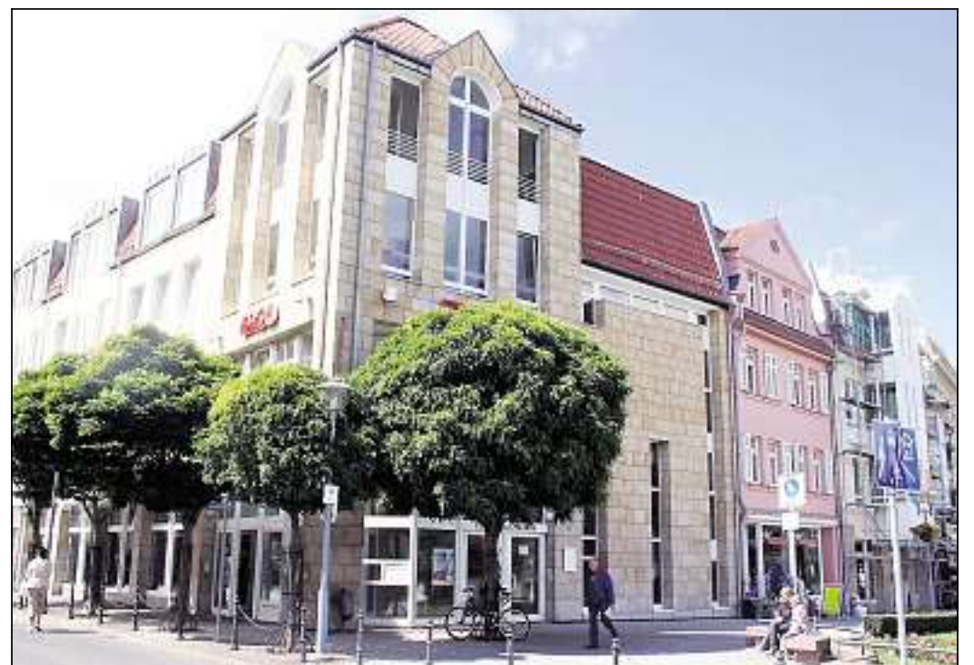
Die zu DDR-Zeiten in der Baulücke aufgestellte Imbissbude konnte keinen gastronomischen Ersatz für das alte „Theater-Kaffee“ darstellen. Erst nach der Wende erfolgte zwischen 1993 und 1995 die Neubauung mit dem sogenannten „Victoria-Haus“.
